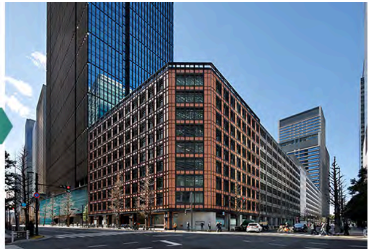
リノベーション後の大手町ビル
