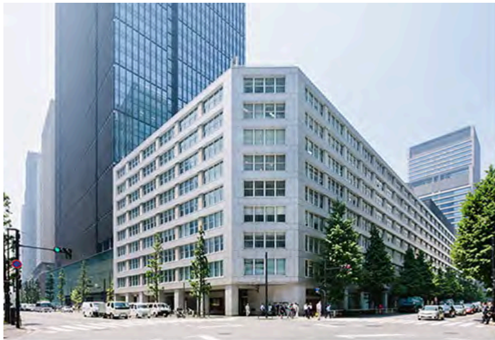
リノベーション前の大手町ビル
