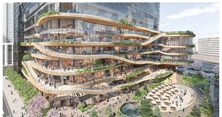
街区南側から見たTorch Tower低層部
