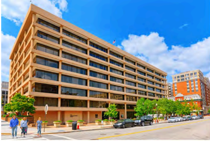
既存建物（前ワシントン首都圏交通局）
