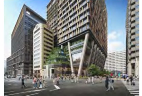
CLTパネルと建物低層部に広がる緑地
