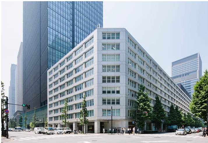
大手町ビルリノベーション前
