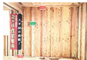
国産木材を採用した壁枠組の 施工事例
