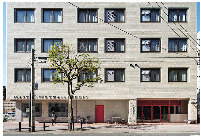
エントランス (after)
