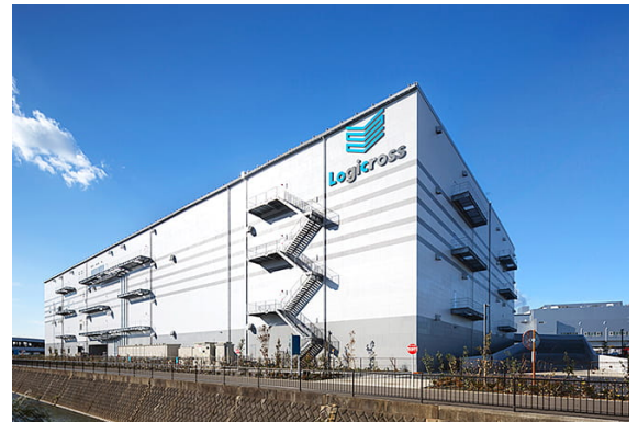
ロジクロス海老名 2020年11月竣工
