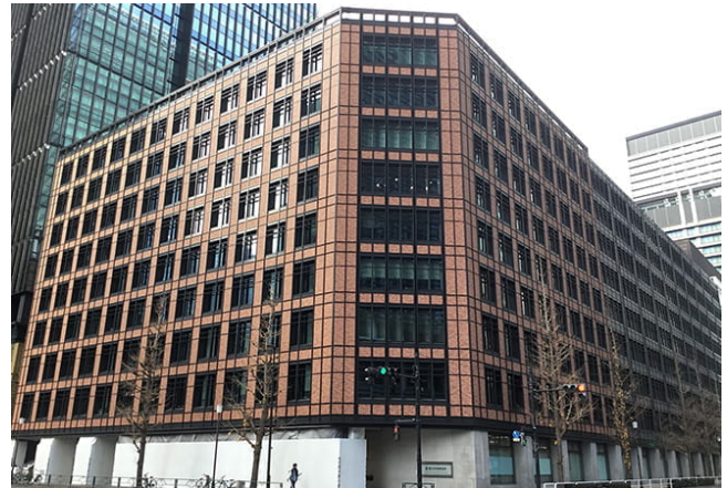
大手町ビルリノベーション後
