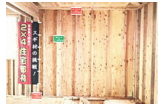
国産木材を採用した壁枠組の施工事例
