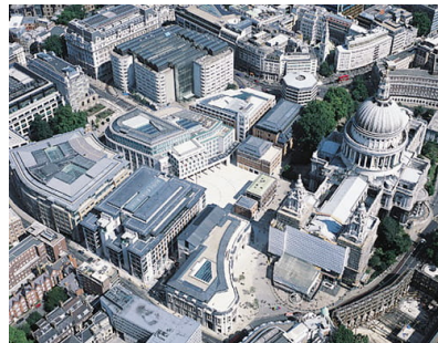
上空写真 (広場左下の四角い建物が本物件)
