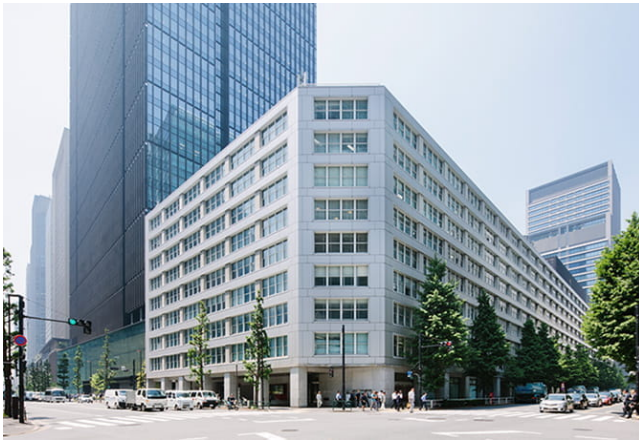
大手町ビルリノベーション前
