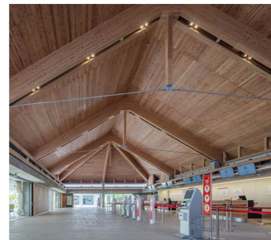
屋根構造材にCLTを使用したチェックインロビー
