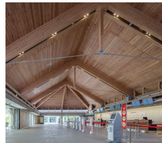
屋根構造材にCLTを使用したチェックインロビー
