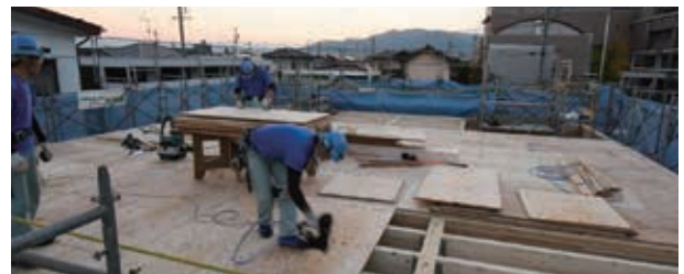
高耐久高耐力壁パネルを用いた施工
