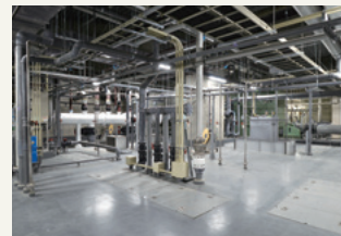
汚水の浄化施設
