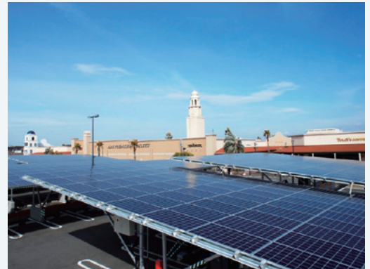
あみプレミアム・アウトレット 自家消費用カーポート型太陽光発電設備
