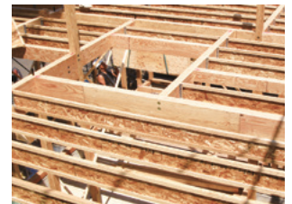
国産材を利用した建設現場
