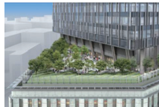
「大名古屋ビルヂング」
