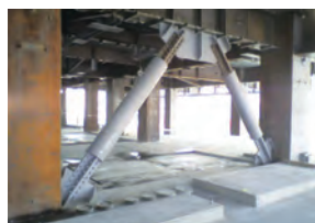
制震装置の例(左: プレースタイプ、右: 壁タイプ)
