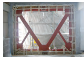
壁の増設・増打ち
