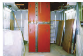
梁・柱の補強
