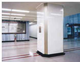
梁・柱の補強
