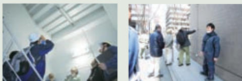
建物診断の様子
