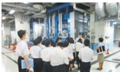
フィールドワークでの地域冷暖房プラント見学の様子
