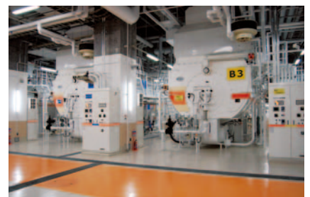
丸の内二丁目センター
