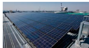
太陽光発電 屋上に最大出力約60kWの太陽光発電パネルを設置
