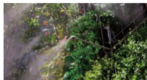
ドライミスト 水を霧状にして噴射し、噴霧気化熱により周辺の温度を抑制
