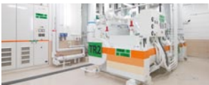
インバーターボ冷凍機 世界最高水準の高効率機器で、冷水をつくる。
