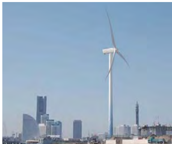
横浜市風力発電事業(ハマウイング)発電風車(定格出力1.980KW)
