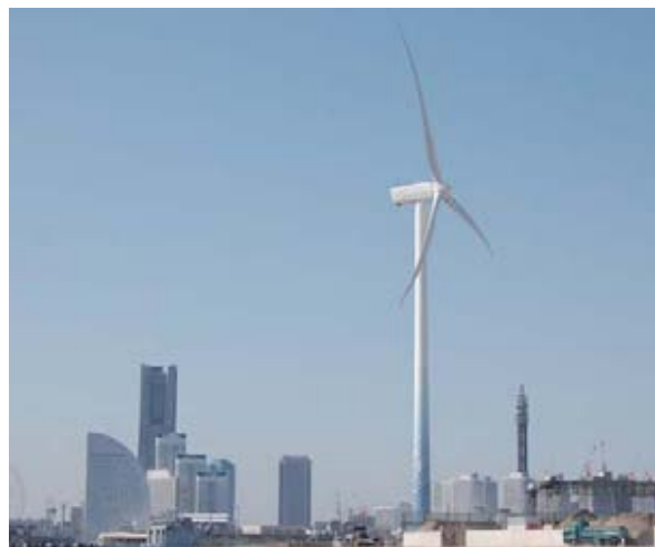
横浜市風力発電事業(ハマウイング)発電風車(定格出力1.980KW)
