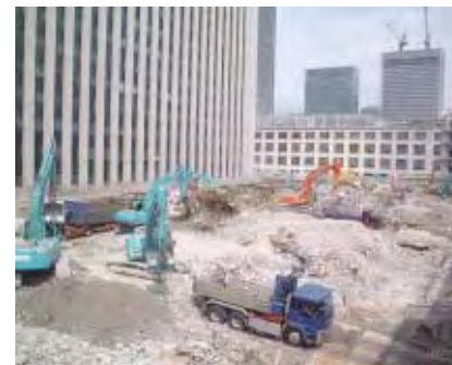
東京ビル解体工事の建設廃棄物
