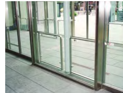
自動ドアの脇に設置した防護柵
