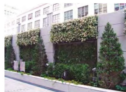
北側を東西に貫通する通路(壁面にハツクキカヅラ等を植栽し、通路は保水性ブロックにて舗装)
