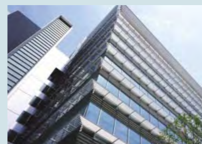
見下ろし防止ルーバーが取り付けられた南側窓面
