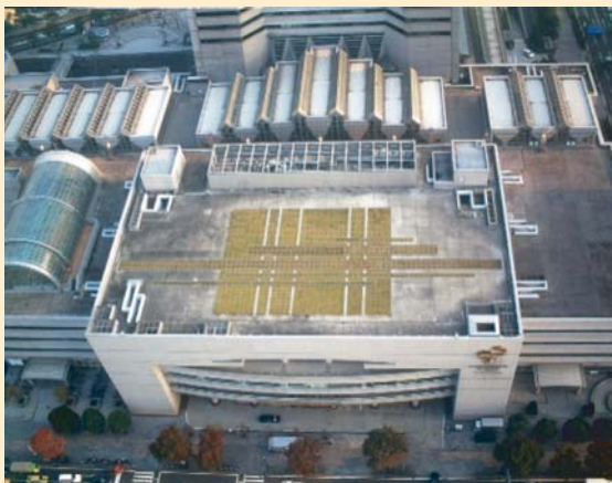
▲三菱重工横浜ビルよりプラザ棟6階屋上を俯瞰した景観
