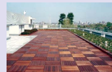
▲ハイマツなどを植栽した屋上は、庭園として学生に利用されている。
