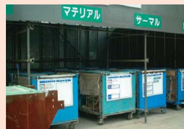
建設廃棄物の分別状況
