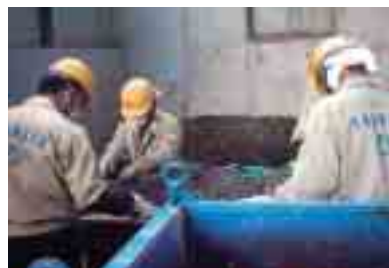
▲建設廃材から可燃物を手作業により抜取り
