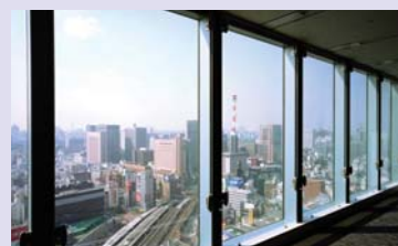
▲窓際の熱負荷を軽減するエアフロー・ウィンドウ
