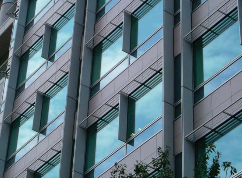
丸の内北口ビル外壁ルーバー (外壁タイルには光触媒作用のある酸化チタンを塗布)
