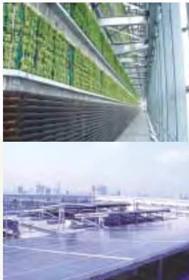
(左上)三菱信託銀行本店ビル屋上壁面緑化 (左下)三菱信託銀行本店ビル屋上太陽光パネル (上)三菱信託銀行本店ビル窓面ひさし
