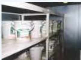
丸ビル地下2階生ゴミ集積所
