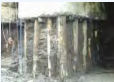
旧丸ビルの基礎松杭
