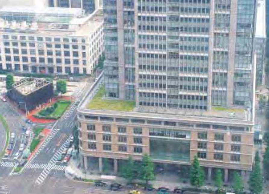
丸ビルの屋上緑化
