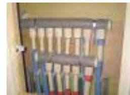
さや管ヘッダー方式には、同時使用時の水量の変化が少ないというメリットもあります。
