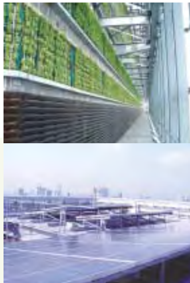
(左上)三菱信託銀行本店ビル屋上壁面緑化 (左下)三菱信託銀行本店ビル屋上太陽光パネル (上)三菱信託銀行本店ビル窓面ひさし
