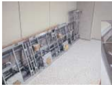
ユニット工法施工時： 下地・配管ユニット施工中
