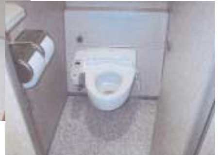
ユニット工法完成時：仕上・便器他取付済
