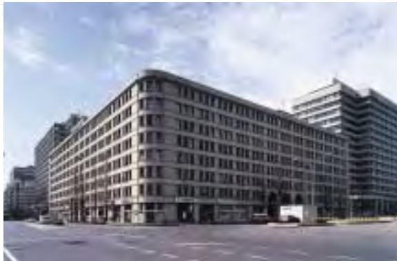
解体前の丸ノ内ビルディング
