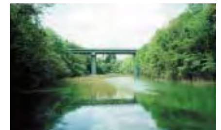
道路堤体部を橋梁に変更した西御門谷津保全ゾーン
