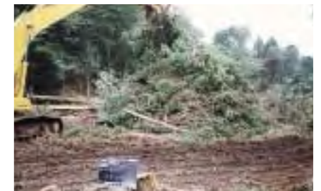
樹木リサイクル 幹は建築用材としての利用 枝はチップ材としての紙の原料化 伐採根はチップ化して造成森林のマルチング材として利用
