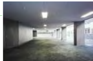
再生資材を使用した車路
